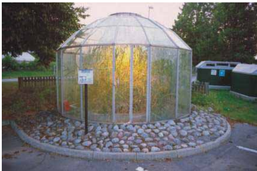
Oczyszczalnia szklarniowa ścieków pochodzących ze stacji benzynowej wchodzącej w skład sieci stacji BP (Szwecja)
