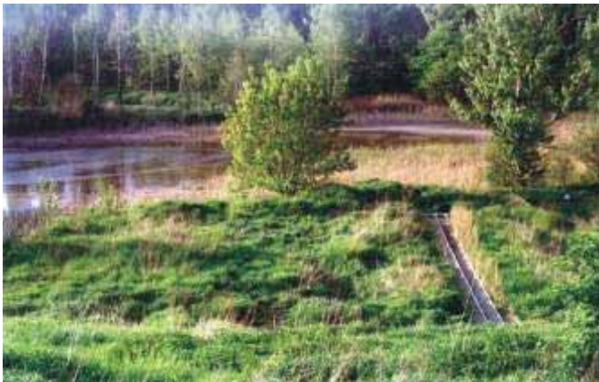
Eksperymentalna oczyszczalnia odcieków na składowisku odpadów komunalnych w Skawinie
