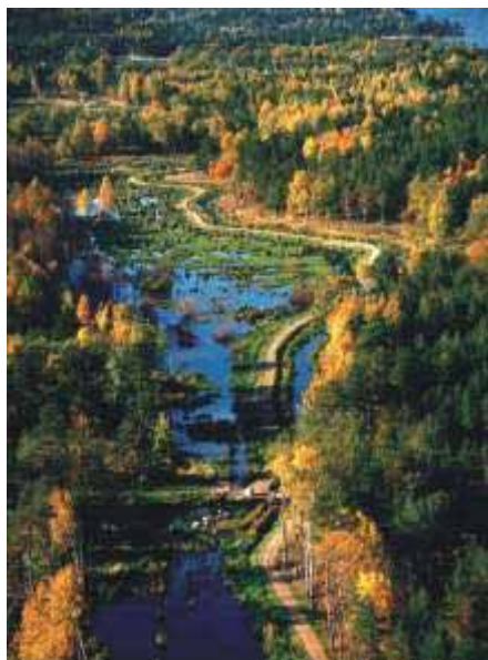
Sztuczne mokradło służące do oczyszczania ścieków komunalnych w Oxelösund (Szwecja) (autor zdjęcia jest Bo Björkdahl)
