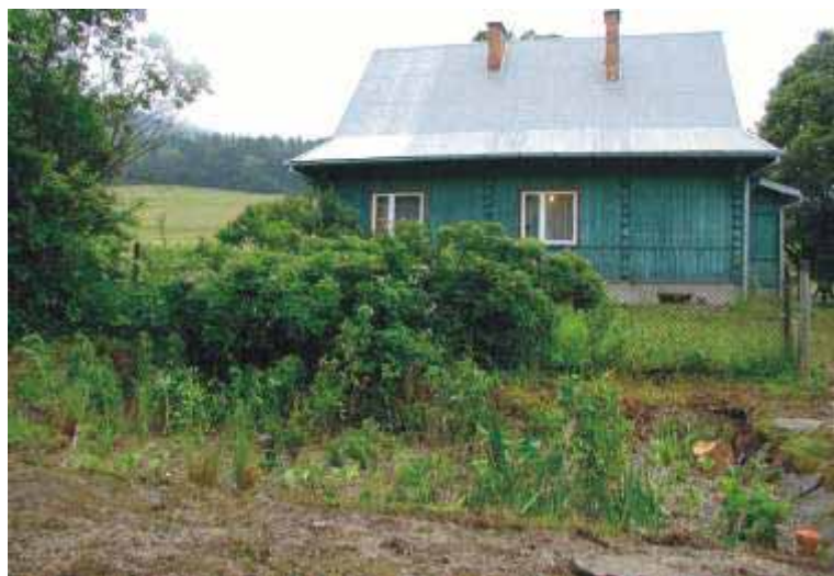
Przydomowa oczyszczalnia ścieków Krempna, Magurski Park
