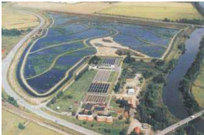
Oczyszczalnia roślinna stanowiąca końcowy etap oczyszczalni ścieków komunalnych w Ekeby (Szwecja, (publikacja za zgodą Eskilstuna Energi & Miljö)
